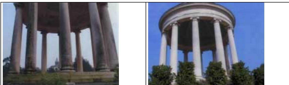
Veduta del basamento e delle colonne Vista esterna del tempio a restauro completo.
