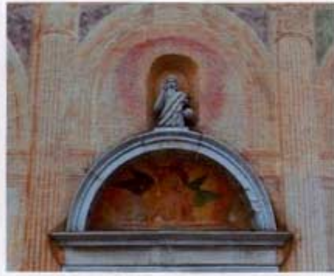
DOPO IL RESTAURO particolare lunetta della Resurrezione foto n° 15
