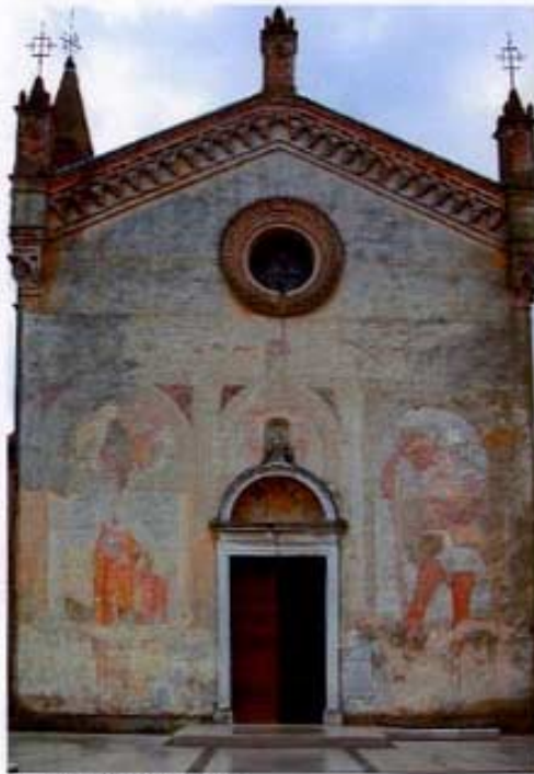
PRIMA DEL RESTAURO veduta d'insieme - foto n° 16
