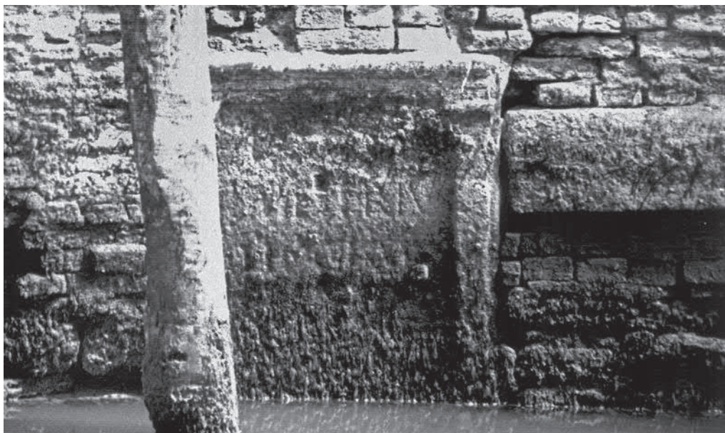
Monumento sepolcrale dei Mestrii alla base della facciata d'acqua di Ca' Soranzo dell'Angelo in rio della Canonica a Venezia.
