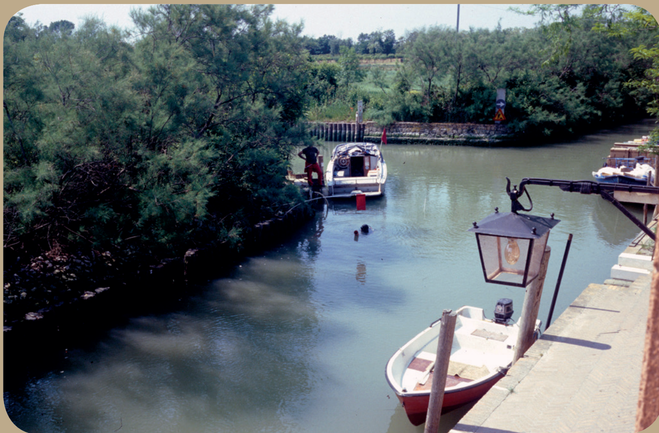
Fig. 8 - Intervento nel canale Maggiore. Scavo con sorbona (2001)
