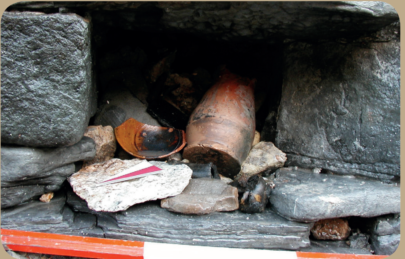
Fig. 4.6,2 - Scarico fognario bassomedievale dell'edificio posto ad Est del Canal Maggiore di Torcello
