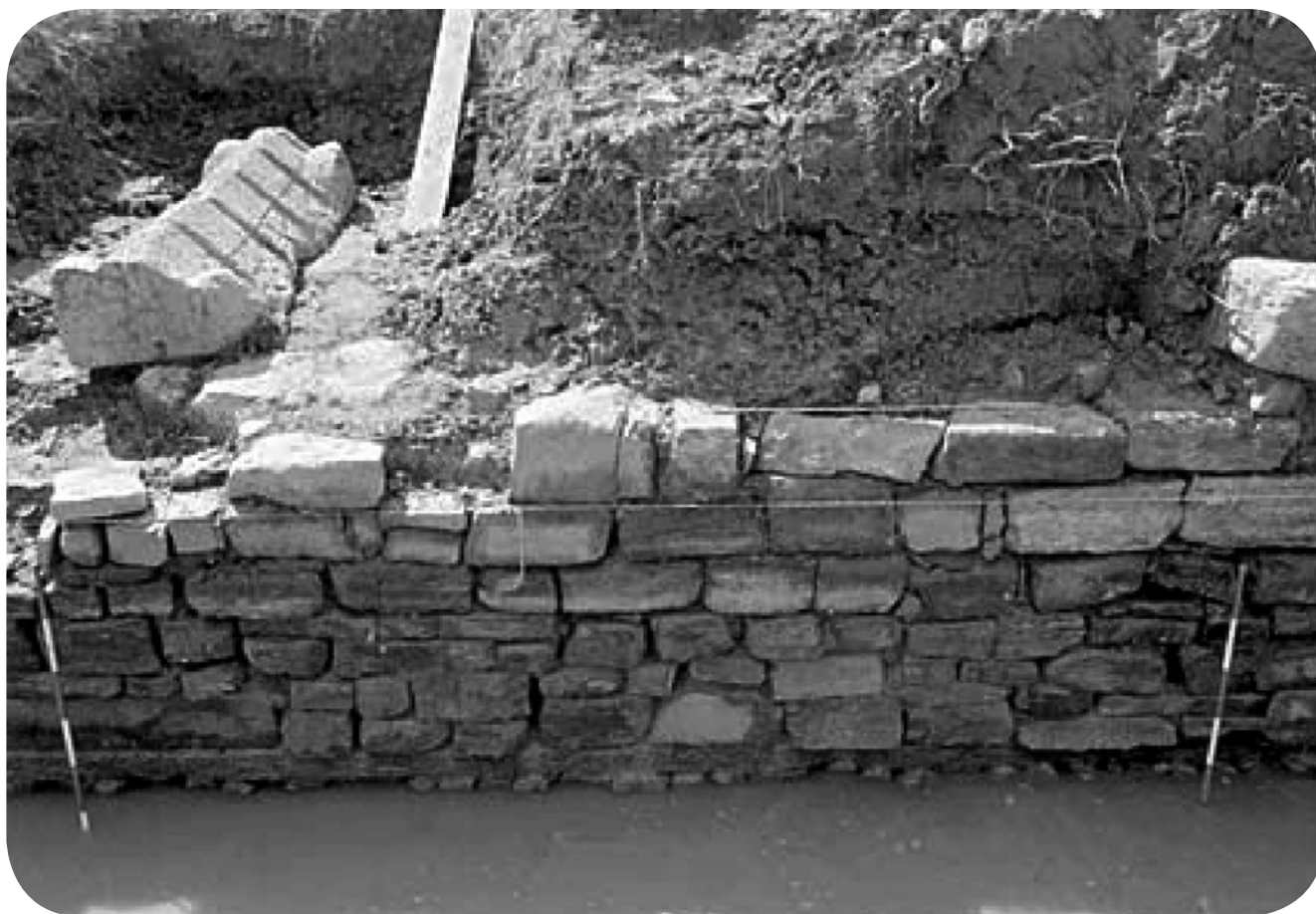
Fig. 1 – Foto prospettica parziale della riva monumentale rinvenuta nel 1996 lungo il canale di Torcello
