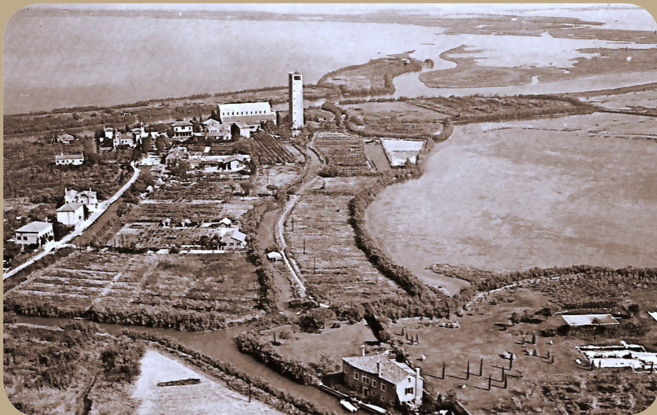
Fig. 3.1 - Vista aerea della Torcello agricola della seconda metà del XX secolo (Collezione privata: A.p.B. Venezia Laguna, Torcello n. 32)
