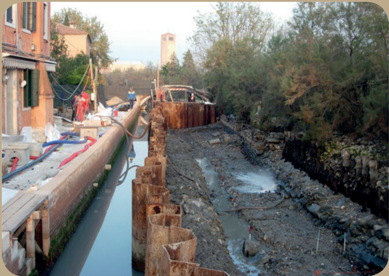
Fig. 2.6,3 - Scavo all'interno del canal Maggiore di Torcello
