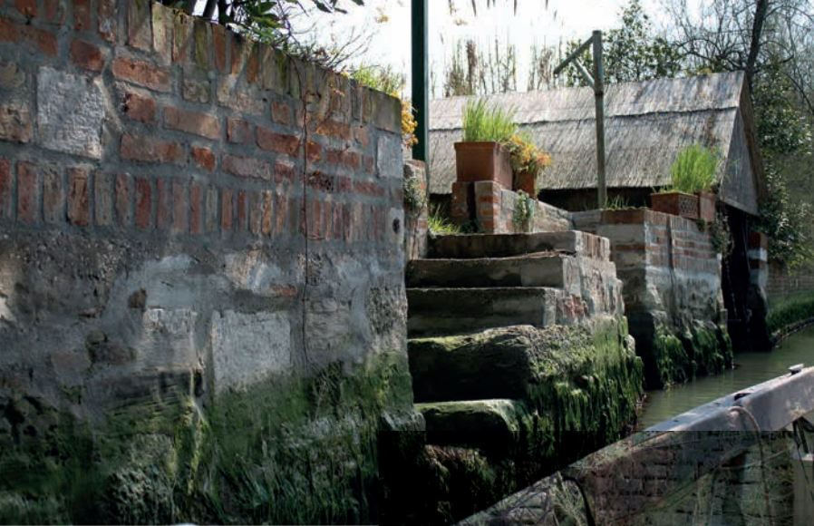
Sodobni utrjeni breg iz ponovno uporabljenega gradbenega materiala
