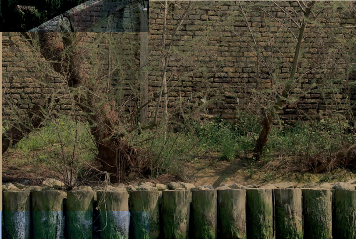
Srednjeveški zid samostana sv. Janeza in sodobni utrjeni breg z lesenimi piloti
