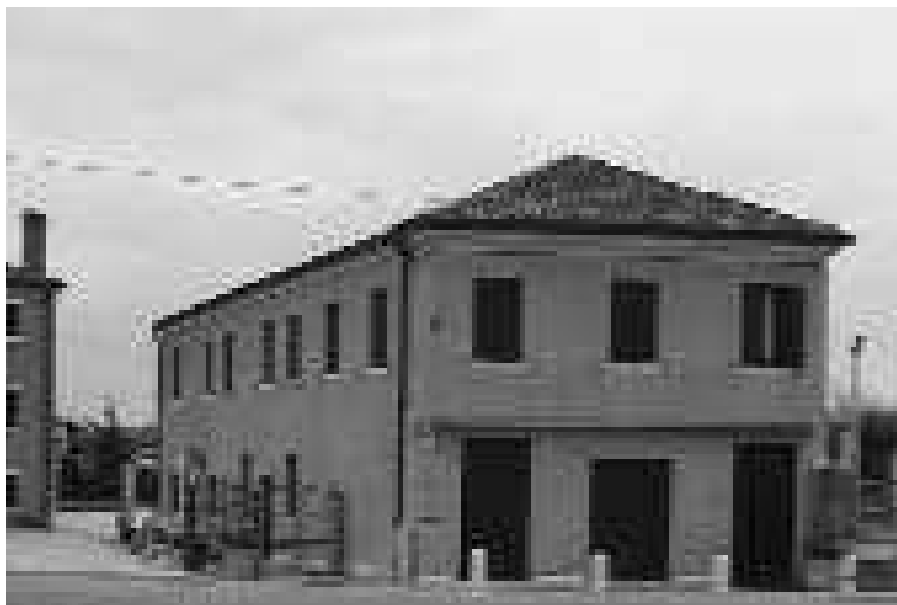
Edificio annesso a nord del complesso (Archivio IRVV)
