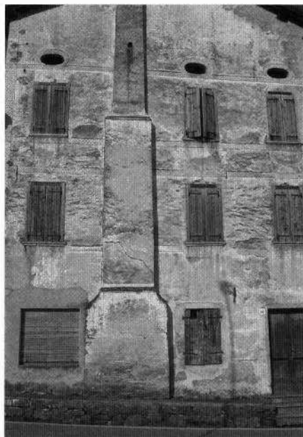
Dettaglio del timpano (L. De Bortoli, 2003) Fronte prospiciente la strada (L. De Bortoli, 2003)
